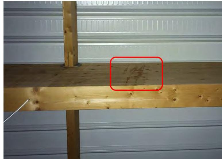
L'eau s'infiltra sous le bandeau en toiture et transite en sous face de la poutre en bois pour s'infiltrer dans le bâtiment. L'eau coule ensuite sur la face supérieure du faux plafond pour tacher la plaque de faux plafond.
