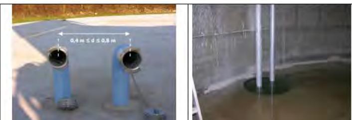
Réserve enterrée munie de deux colonnes fixes d'aspiration de 100 mm
