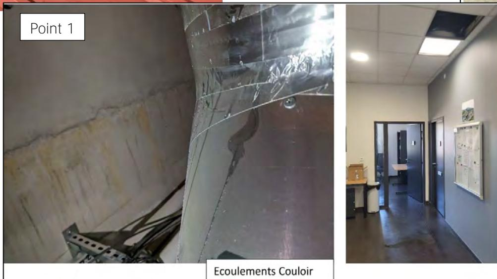
Les points 2 et 3 proviennent de l'infiltration sur le puit de lumière au point 1. Cette infiltration suit une poutre dans les combles et coule en raison de fixation sur cette poutre.
