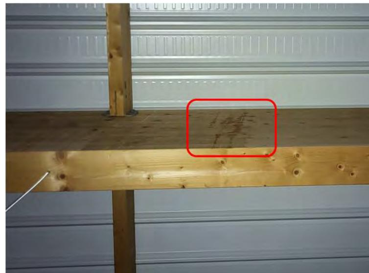
L'eau s'infiltré sous le bandeau en toiture et transite en sous face de la poutre en bois pour s'infiltrer dans le bâtiment.
