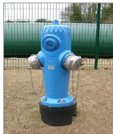
Poteau d'aspiration classique de 150 mm, muni de deux sorties de 100 mm et d'un carré de manœuvre.
