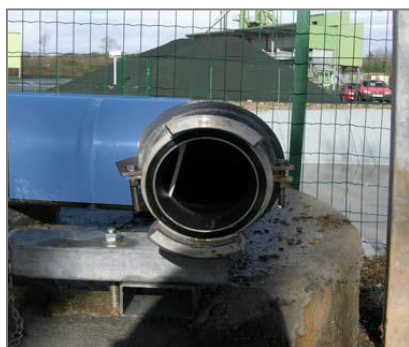
Une sortie de Ø100 mm avec les tenons verticaux (l'un au-dessus de l'autre)
