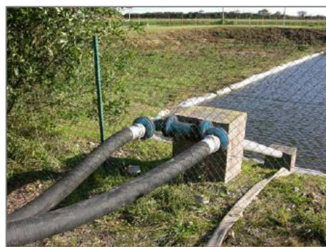
Deux sorties de Ø100 mm sur une colonne de Ø150 mm
