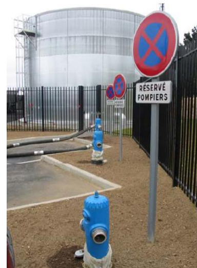
Réserve aérienne équipée de 3 poteaux d'aspiration de 150 mm
