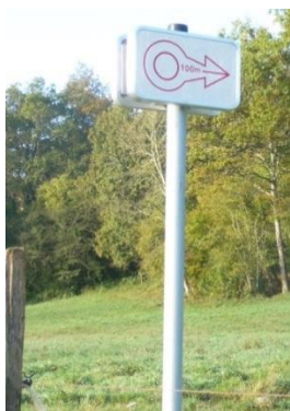
Disque avec flèche signalant un point d'eau utilisable par les secours à une distance de 100 mètres
