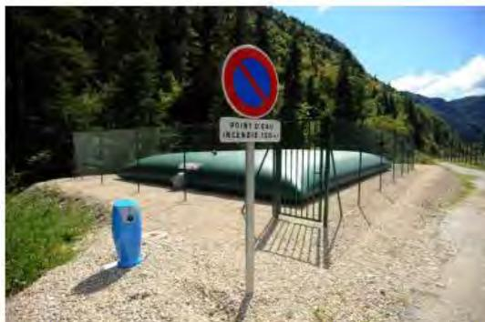
Dispositif avec un poteau d'aspiration alimenté par une réserve incendie souple
