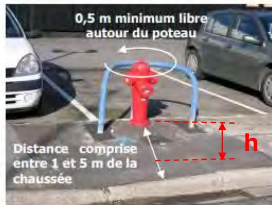
***h = 450 mm (pour les PI DN 80mm et de DN 100) et h = 550 mm pour les PI de DN 150 mm avec, pour les deux cas, une tolérance de +100 mm ou -50 mm***
